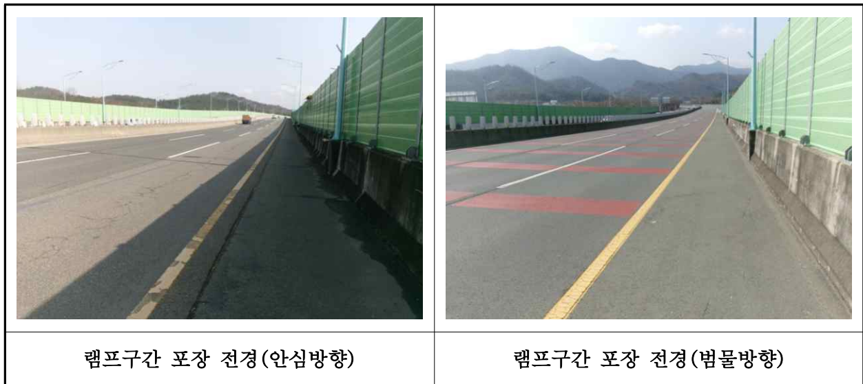
【사진 3.3.25】 램프구간 포장 전경
