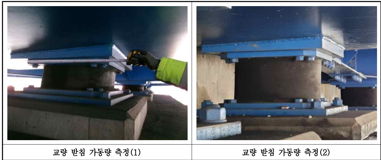
【사진 3.3.15】교량받침 이동량 측정
