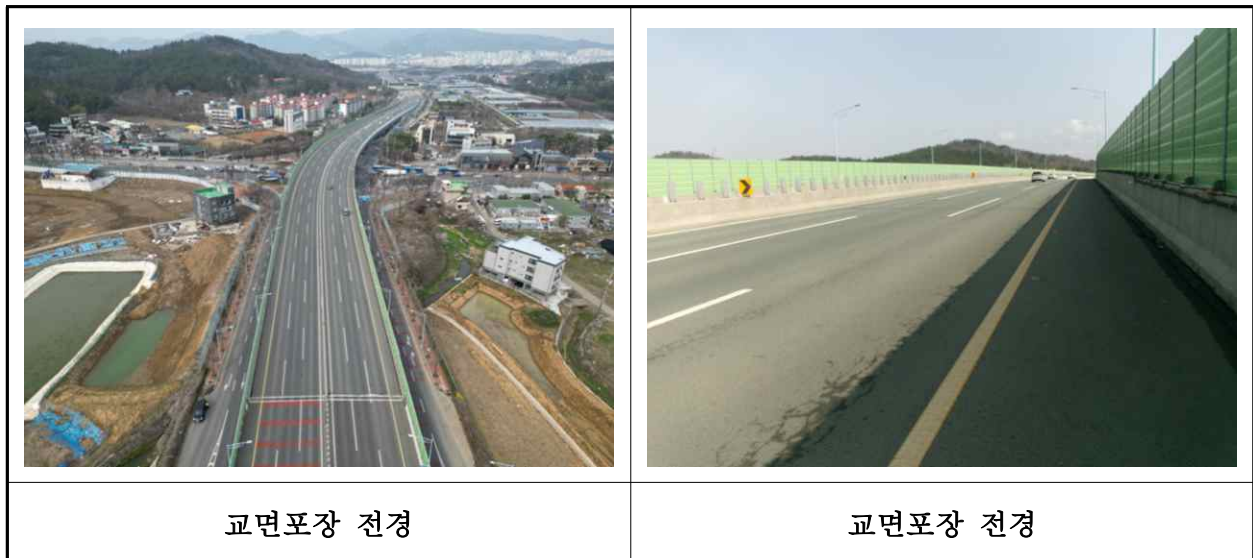
【사진 3.3.19】 교면포장 전경
