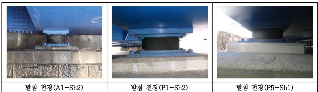
【사진 3.3.12】 교량받침 전경
