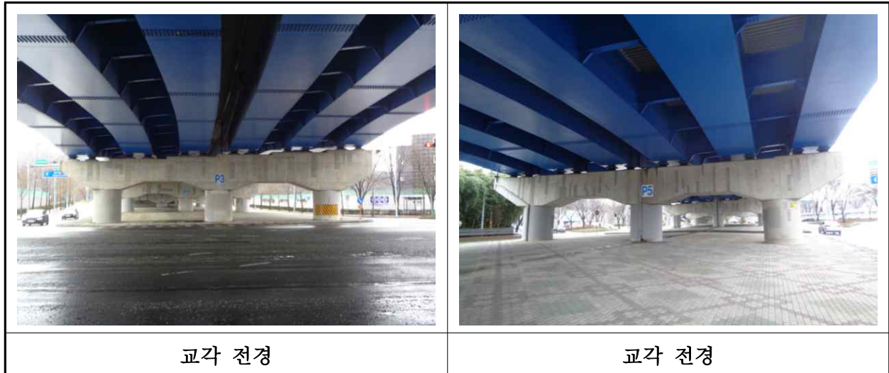
【사진 3.3.10】 교각 전경
