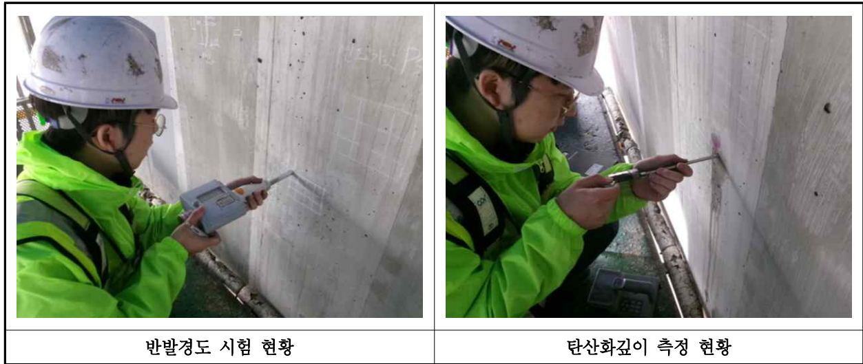
【사진 3.4.1】 콘크리트 내구성조사 현황
