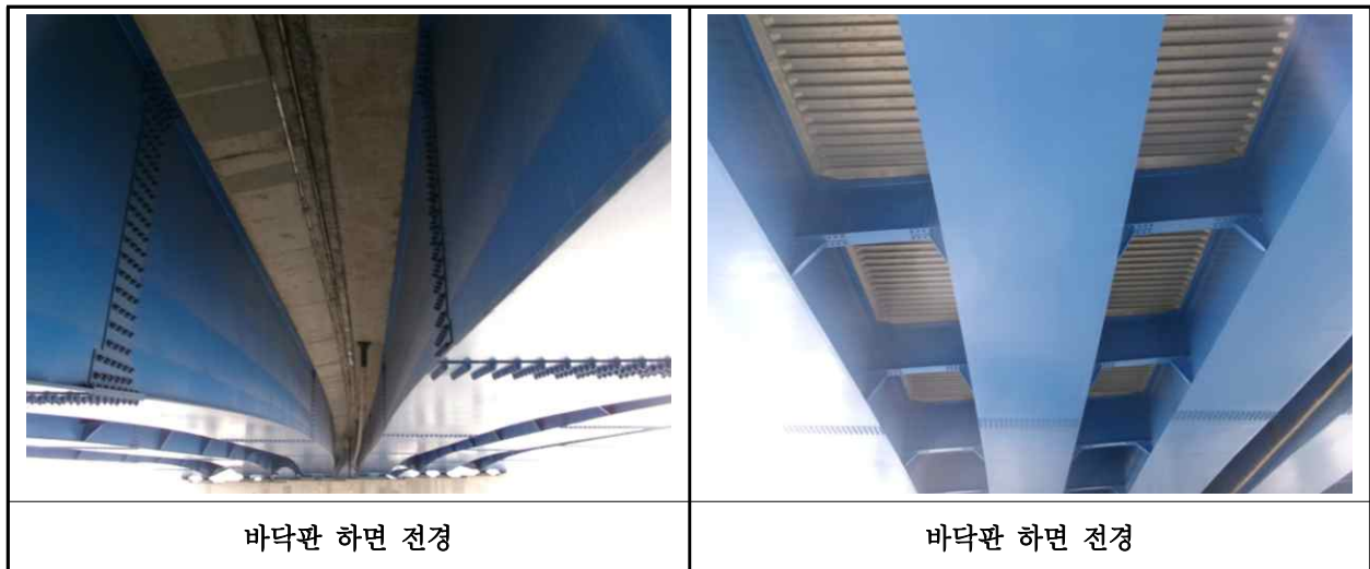
【사진 3.3.2】 바닥판하면 전경
