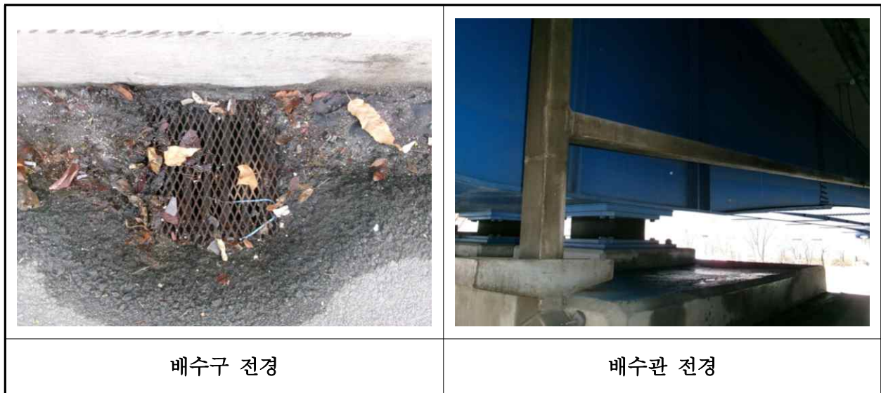
【사진 3.3.21】 배수시설 전경
