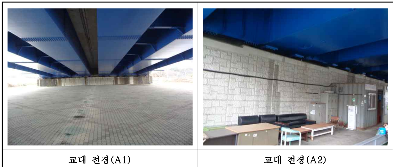
【사진 3.3.8】 교대 전경
